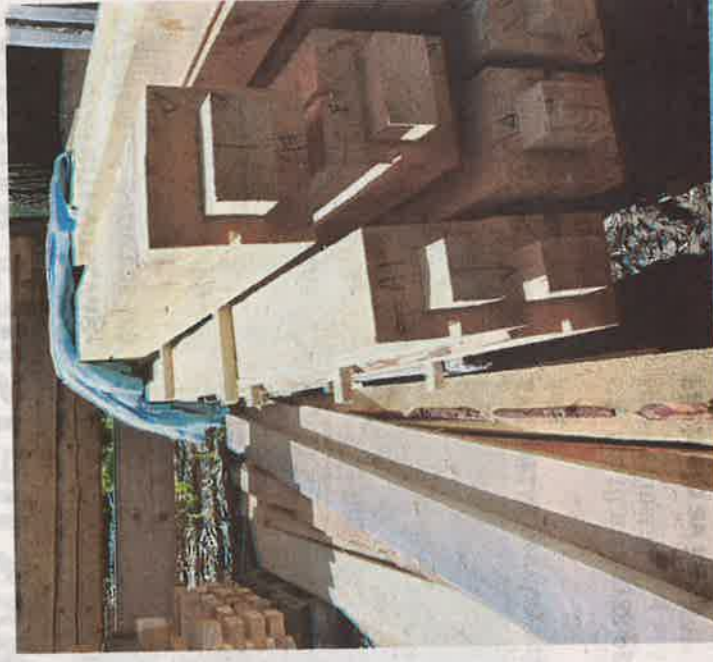
BYGGESETT: Ferdige staver ligger klare til å fraktes til Reine, hvor bygget skal settes sammen.
