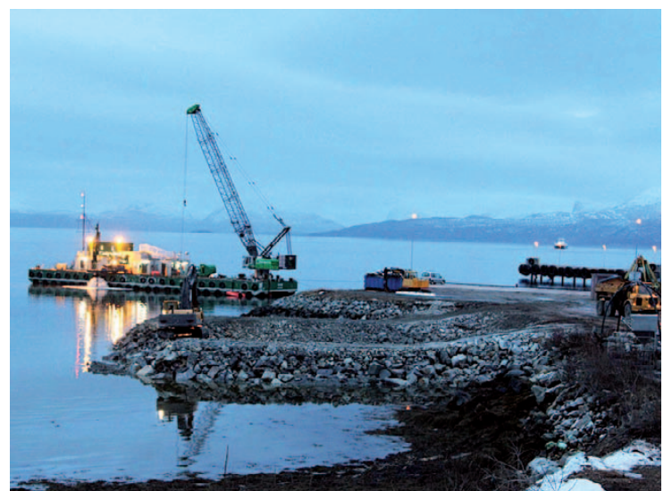
Fleirbrukskaia på Drag under bygging.
